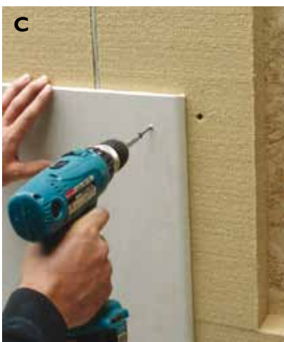
C Bevestigen van gipskarton/gipsvezelplaat
