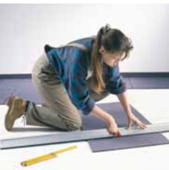
GUTEX Happy Step wordt zwevend in verband geplaatst. Als eindafwerking komt laminaat, kant en klaar parket of tapijt in aanmerking.
