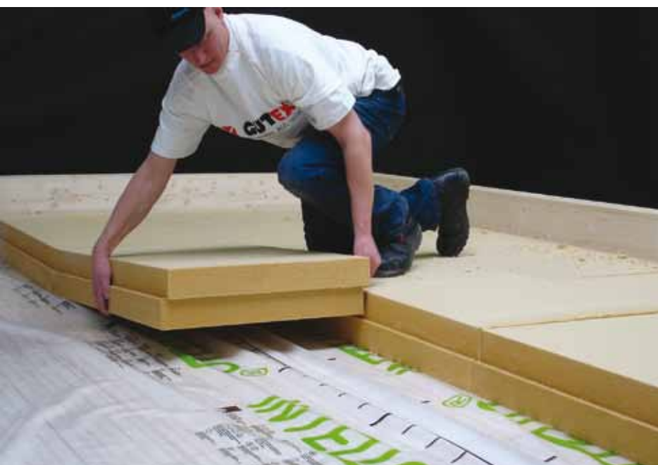
▼ Plaatsing GUTEX Thermoflat
