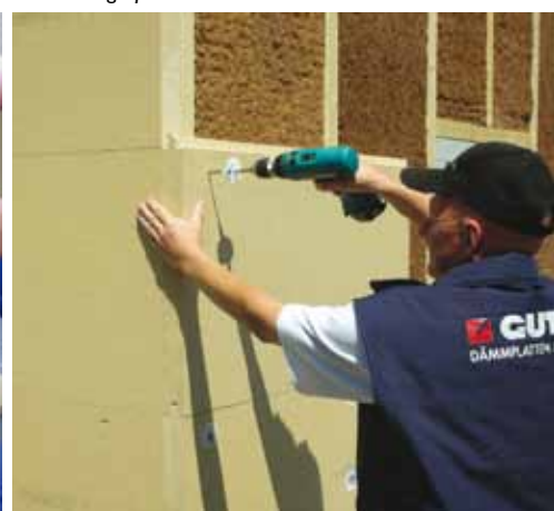
▼ Plaatsing op houtskelet
