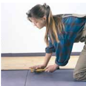
GUTEX Happy Step wordt zwevend in verband geplaatst. Als eindafwerking komt laminaat, kant en klaar parket of tapijt in aanmerking.
